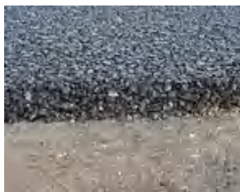
Рис. 1. Основний шар асфальтобетону.
