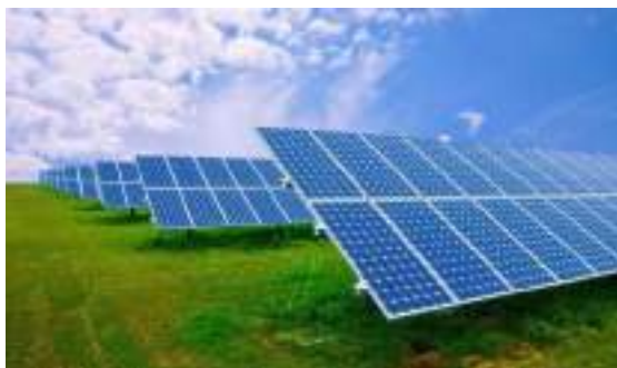
Рис.1. Загальний вигляд сонячної електростанції
