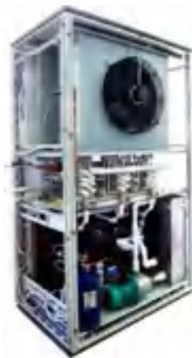
Рис. 2. Випрямляч ГАЛС-6300Р-12-УХЛ із рідинним охолодженням
