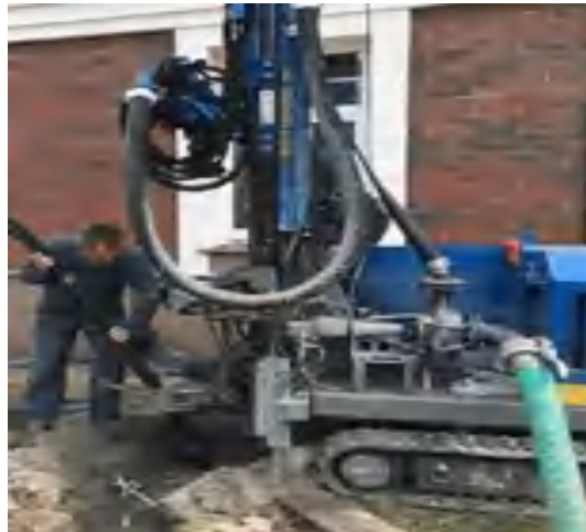
Рис. 4. Приклад встановлення геотермального зонд виробництва фірми Frank.
