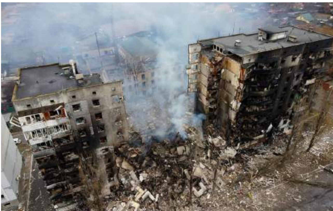
Рис.3. Будівля після прильоту ракети
