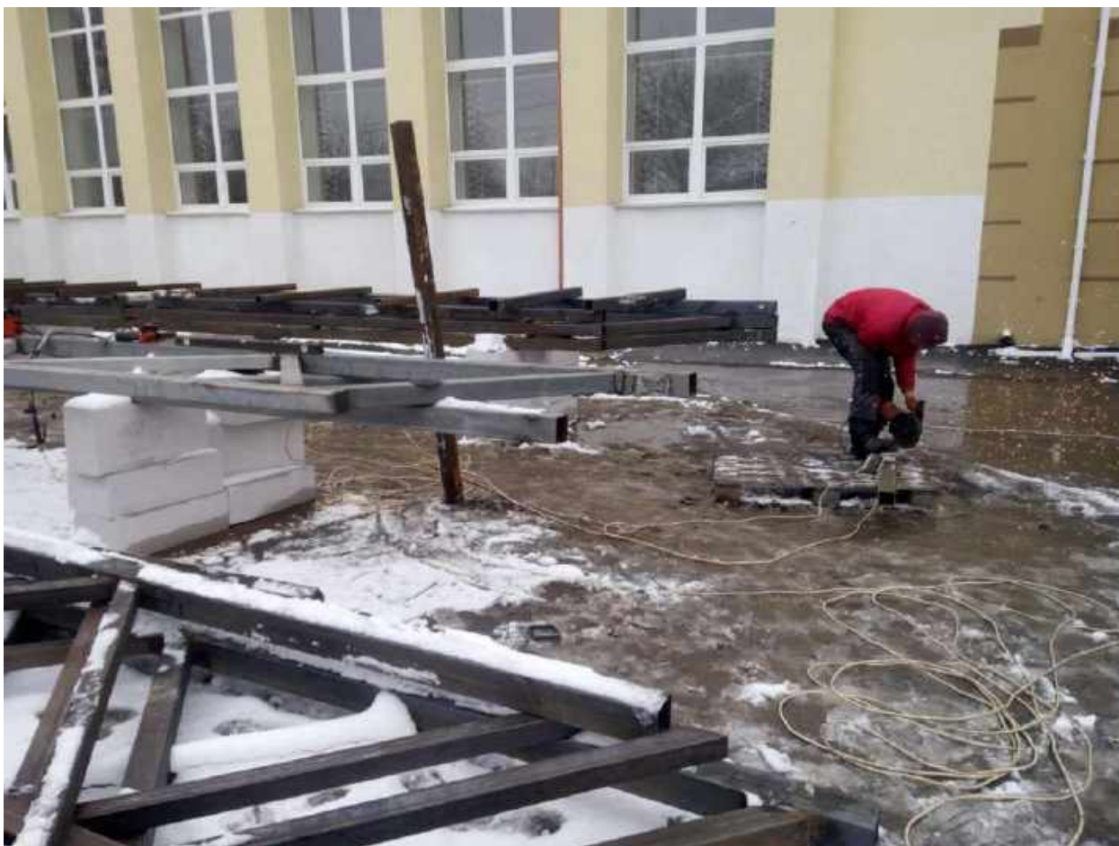
Реконструкція частини покрівлі над навчальним корпусом №3
