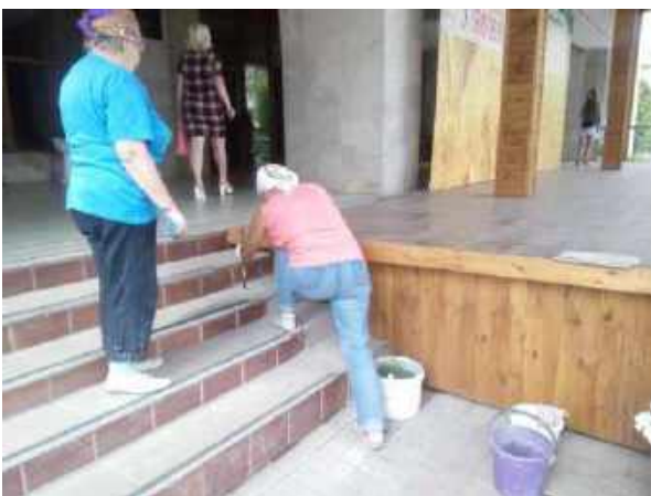
Частковий ремонт сходів навчального корпусу № 2
