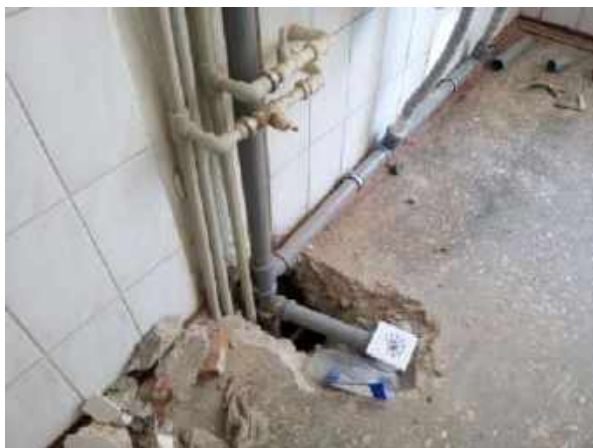
Заміна трубопроводів водопостачання та водовідведення гуртожитку №3
