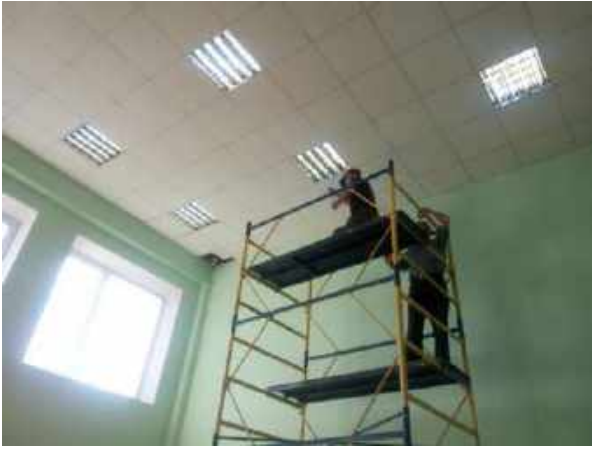
Заміна ламп та стартерів у навчальному корпусі №1
