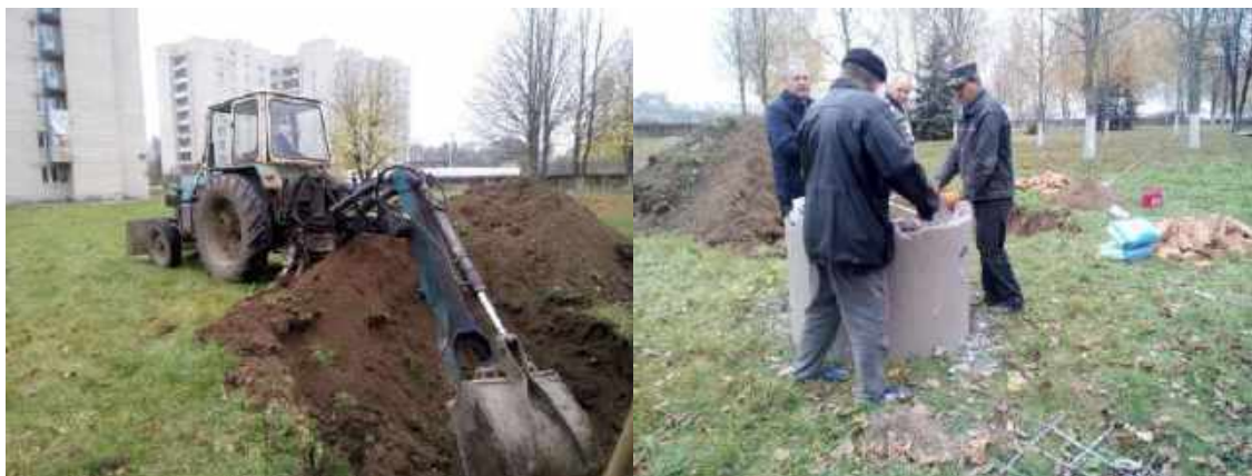
Улаштування оглядового колодязя на трасі гарячого теплопостачання
