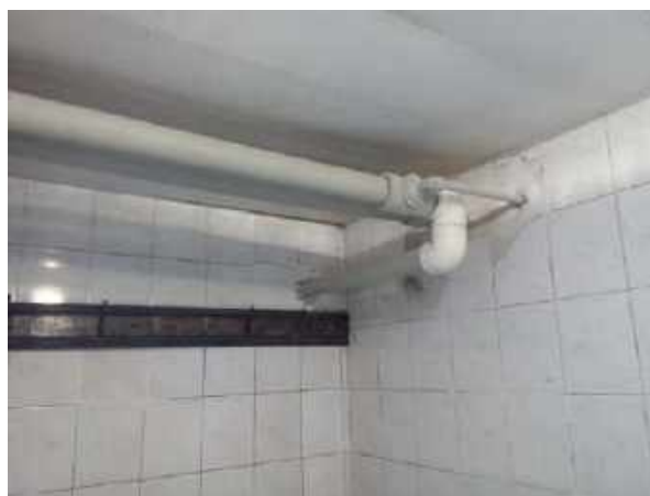
Заміна трубопроводу гарячого водопостачання
