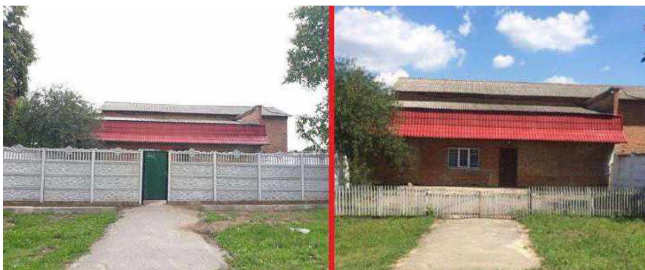
Фото офісу НДГ «Агрономічне» Вінницького національного аграрного університету до та після встановлення огорожі
