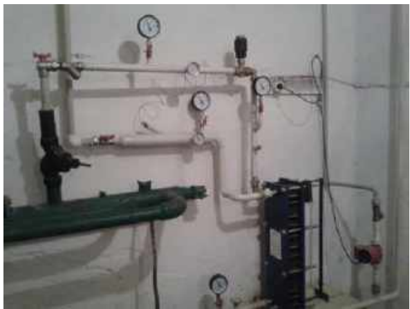
Ремонт водонагрівача та запірної арматури гуртожитку №3
