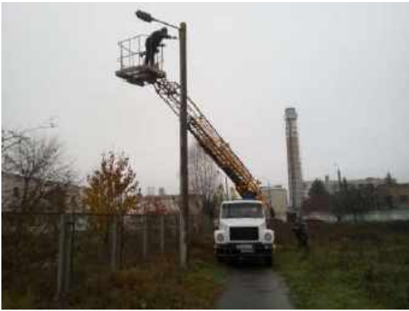
Заміна ламп вуличного освітлення
