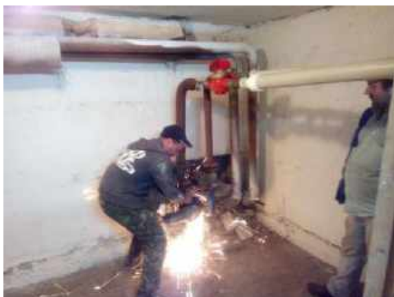
Сантехнічні роботи по заміні трубопроводу гарячого водопостачання
