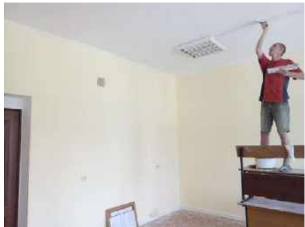
Ремонтні роботи в аудиторіях навчального корпусу №2
