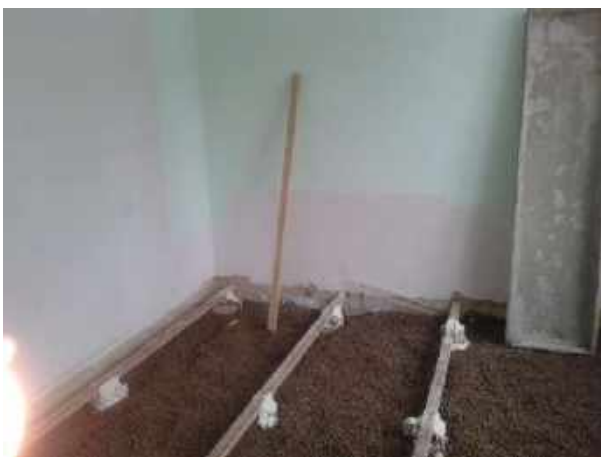
Улаштування підлоги з ламінату в приміщенні студмістечка
