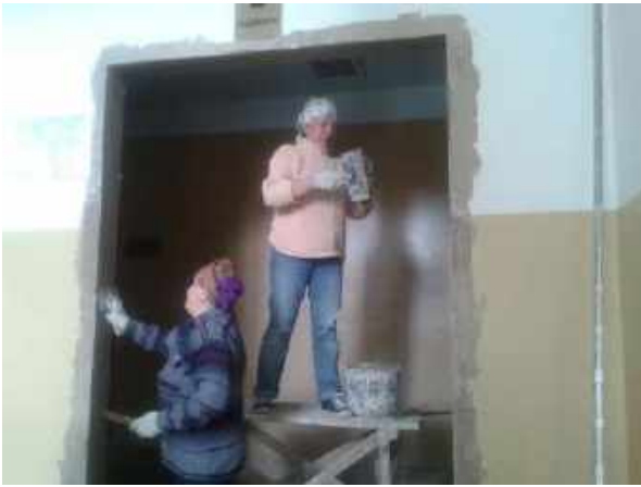
Ремонт коридору навчального корпусу №3
