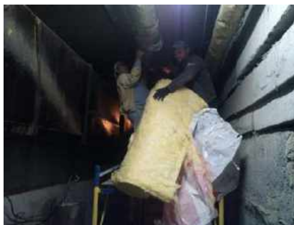
Ізоляція трубопроводів опалення навчальних корпусів
