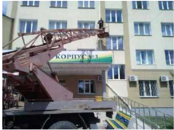
Ремонт системи водовідведення навчального корпусу №3
