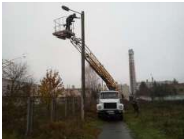
Заміна ламп вуличного освітлення
