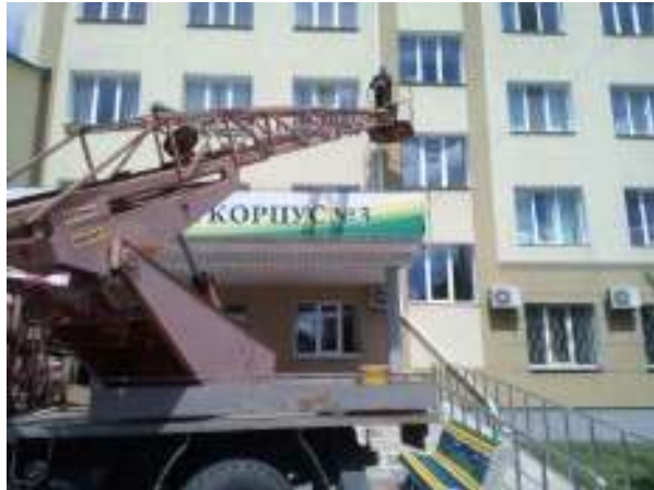
Ремонт системи водовідведення навчального корпусу №3
