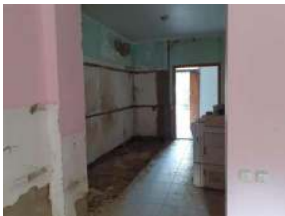
Ремонтні роботи на кафедрі готельно-ресторанної справи та туризму
