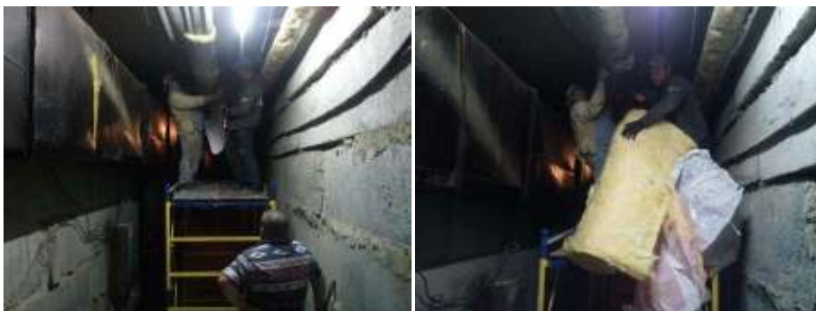
Ізоляція трубопроводів опалення навчальних корпусів
