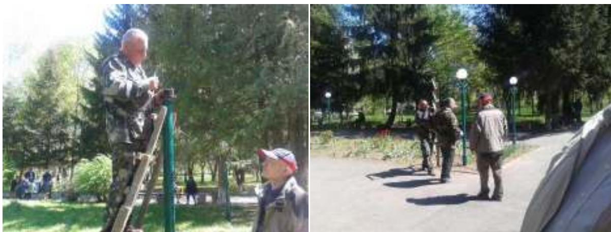
Заміна світильників вуличного освітлення
