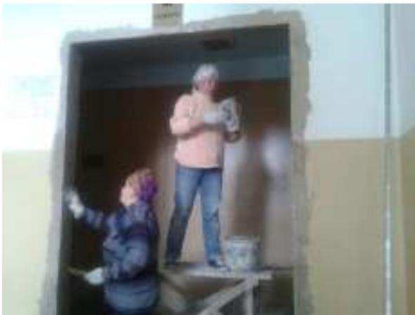
Ремонт коридору навчального корпусу №3
