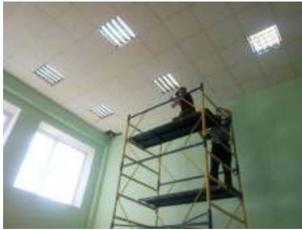
Заміна ламп та стартерів у навчальному корпусі №1
