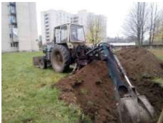
Улаштування оглядового колодязя на трасі гарячого теплопостачання
