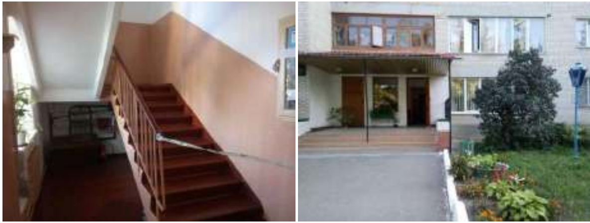
Поточний ремонт у гуртожитку №3
