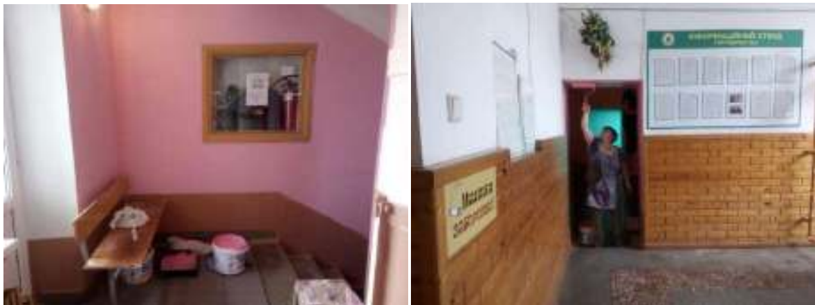
Ремонт блоків та сходових маршів гуртожитку №2
