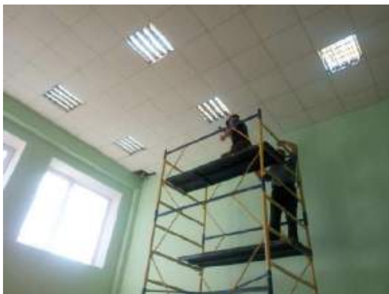
Заміна ламп та стартерів у навчальному корпусі №1
